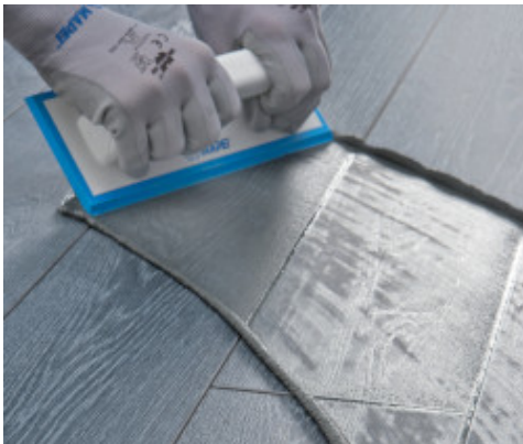
Ultracolor Plus paskleidimas ant grindų, naudojant guminę mentelę
