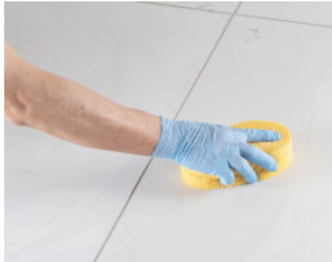
Siūlių valymas ir apdaila su kieta celiuliozine kempinėle
